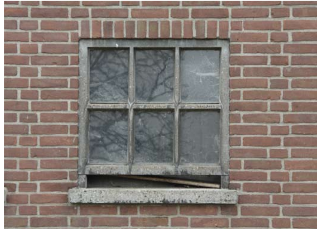
Schokbeton stalramen met ventilatiestrook.
