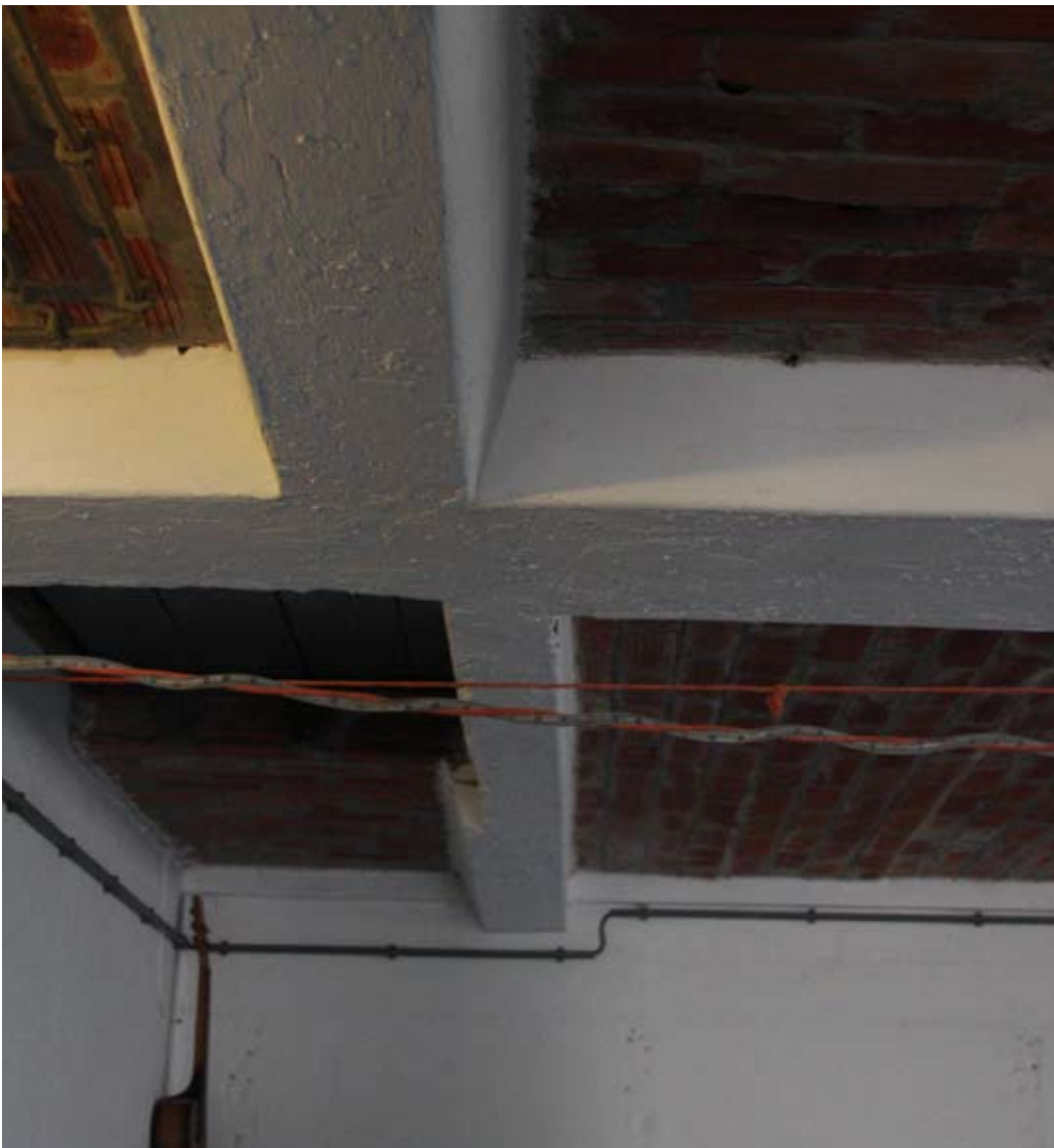
Holle bakstenen elementen op betonnen balken. Daartussen wapening en specie.
